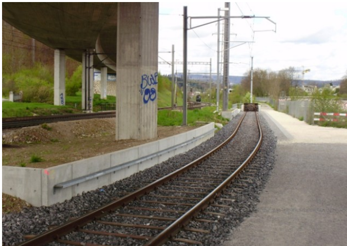
Gleis 19 mit Anprallschutz vor dem Brückenpfeiler
