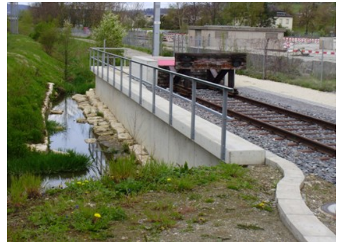
Süessbachanpassung mit Stützmauer und Prelblock
